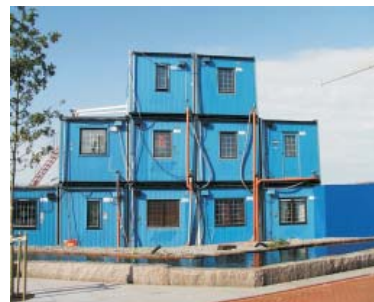
Första steget vid nybyggnation
